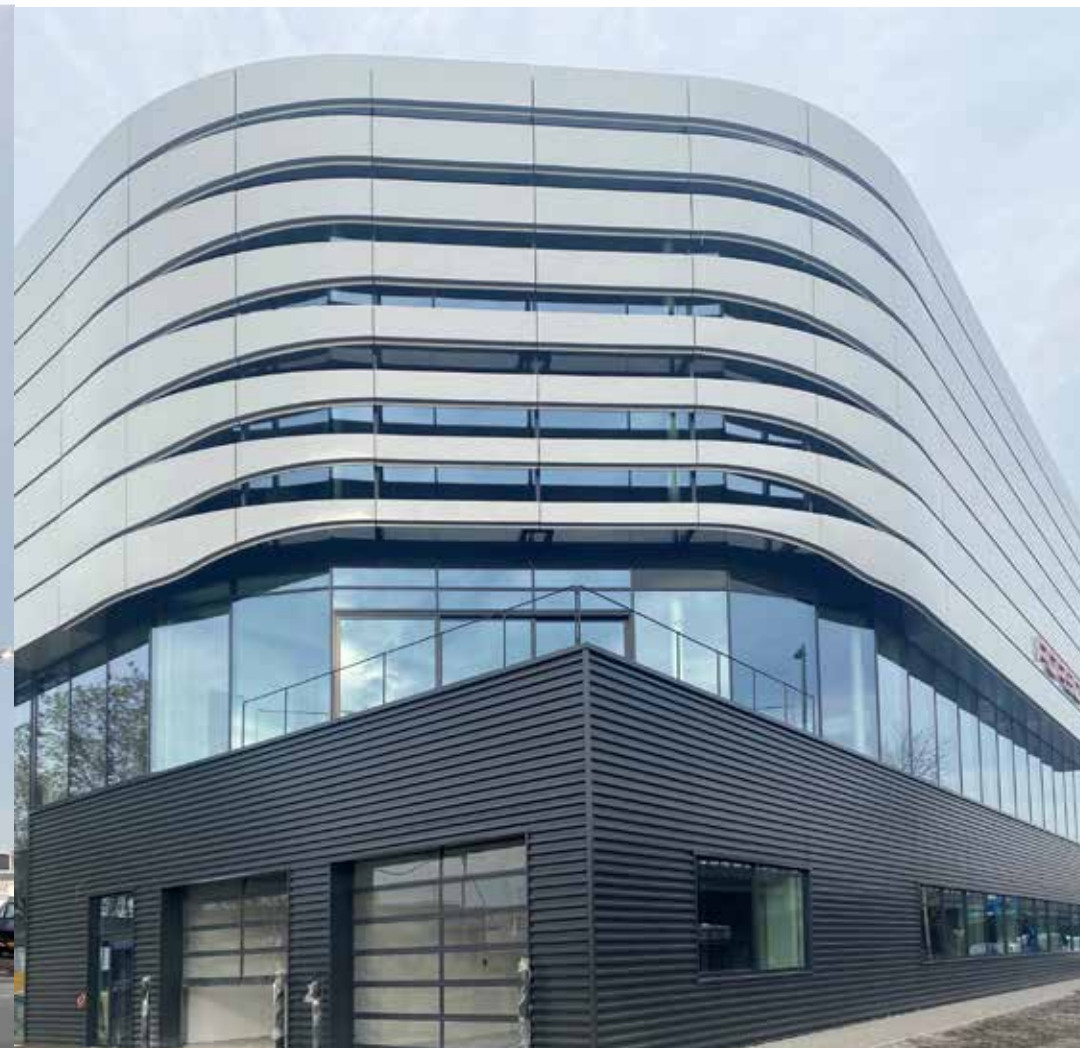
De ronde kopgevel bood forse uitdagingen in ontwerp en engineering.
